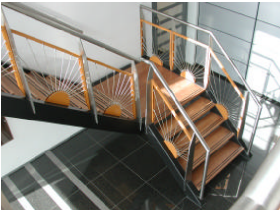
Leuningwerk trap en design-bordes. Halve maanvorm met staaldraad.
