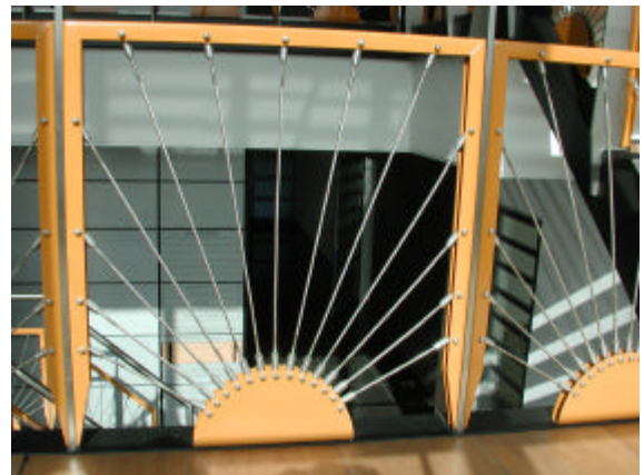
Leuningwerk trap en design-bordes. Halve maanvorm met staaldraad.
